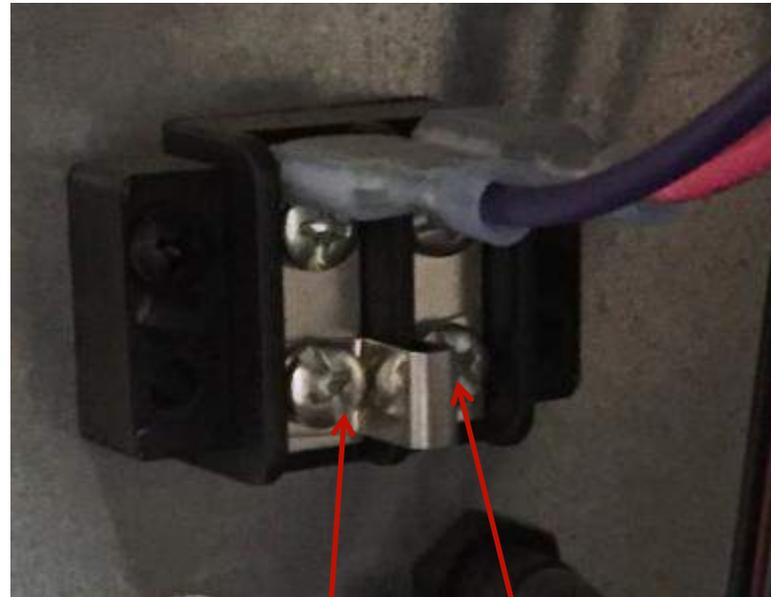
Conecte 2 cables del control remoto a las terminales después de quitar el puente
